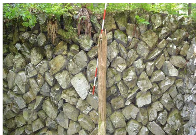
写真5 檜原風穴（3号）の西側内壁面の石垣 （矢羽根状に斜めに積まれている）
