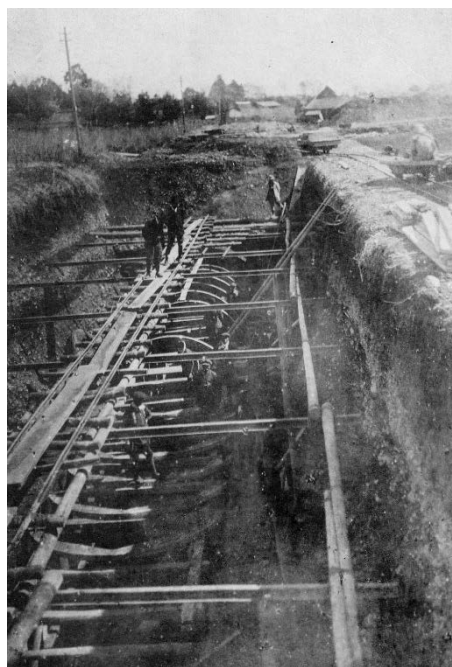
羽村・村山線工事(水道歴史館)
