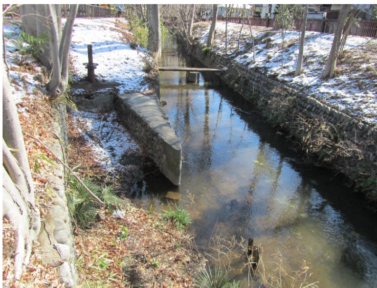
千川上水口跡
