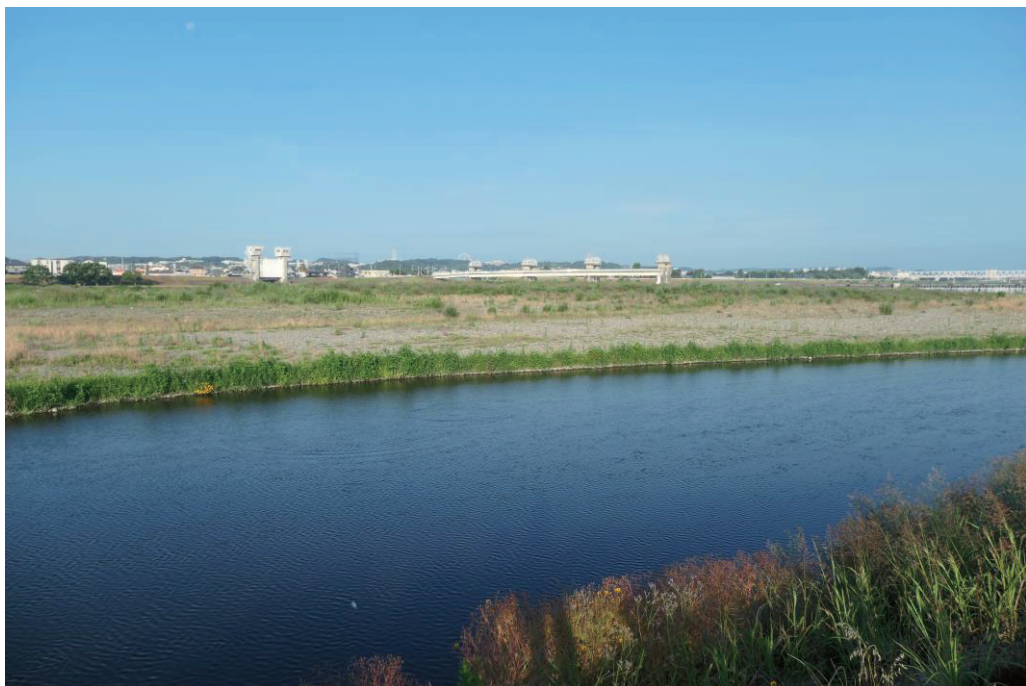
図 4-3 富栄養立地の代表的な地点(St23:上河原堰下流 2021/6/28)
