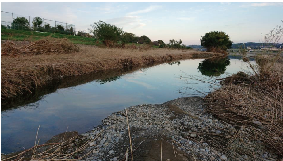
図 2-8 府中四谷橋下流に出現したワンド(河口より約 36km:2019/10/30)
