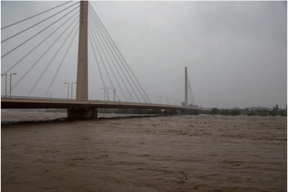
図 2-3 府中四谷橋付近の増水状況(2019/10/12 16 時頃(ピーク前))
