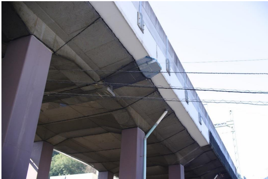
図7 可聴音を確認した京王線の高架橋
