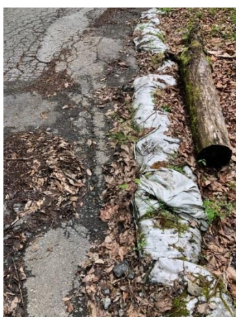
写真 30 【林道脇に設置され放置された土嚢】
