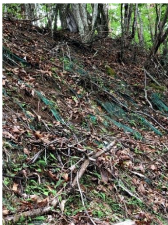
写真 28 【露出した法面に設置された土留めネット】
