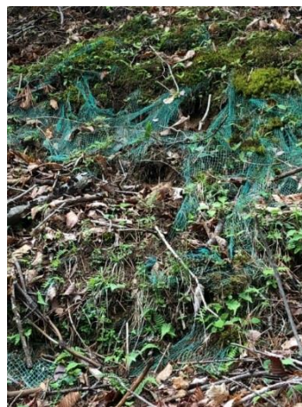
写真 29 【風雨にさらされてボロボロになっている】
