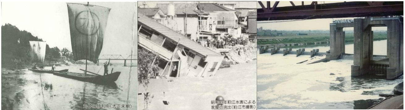
写真 0-1-04 二子砂利舟 (大正末期) 砂利の採掘は堤防の破壊、河床の低下、水質汚濁など環境破壊の一因となった。砂利の需要は多く、運搬用の鉄道が出来るほどだったが、ダムや堰が出来た為、上流からの石の供給もなくなり、多摩川では1965年に全面禁止となった。 撮影者不明
