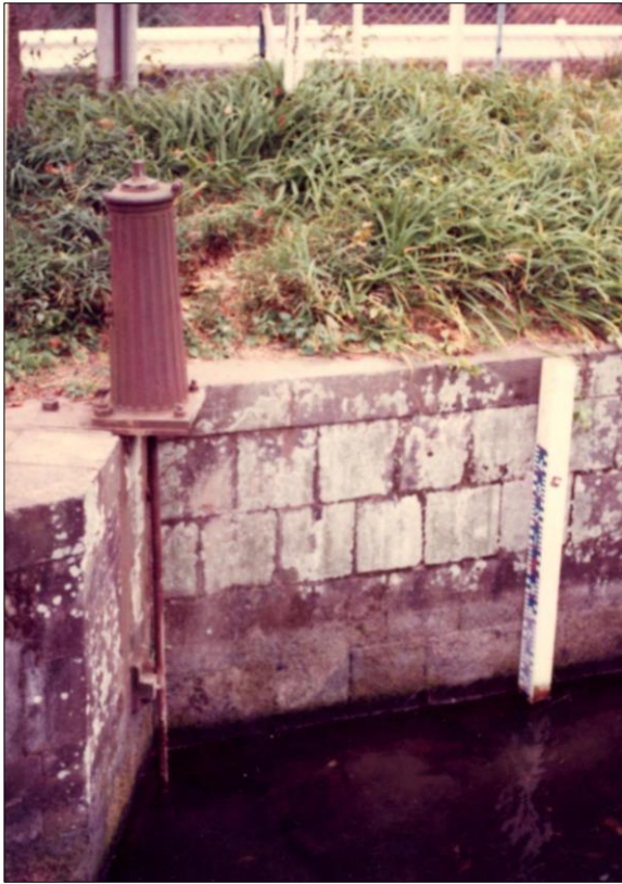
写真 II-3-7-1 源五右衛門分水口を側面から見たところ。
