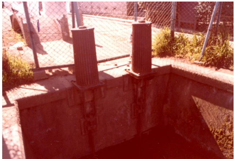
写真Ⅱ-3-16-2 分水口の巻き上げ機(2001年)
