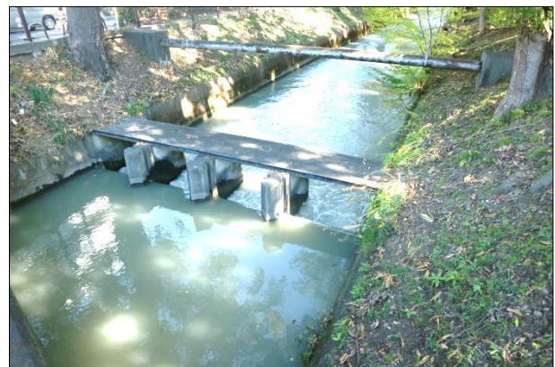
写真Ⅱ-3-3-4 分水口のすぐ下流部にある「小堰」
