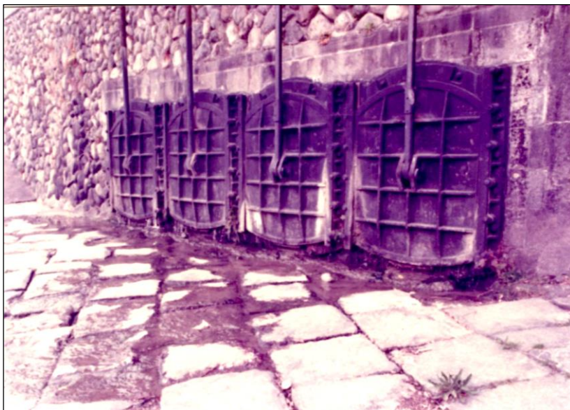
写真Ⅱ-3-A-2 一之水門の鉄扉 多摩川から水が入っていない時に 撮影したもの(2001年頃)
