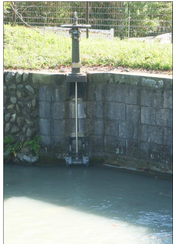
写真 II-3-7-3 (2019年撮影) 源五右衛門分水口を正面から見たもの。水面すれすれの所に取水口がみられる。
