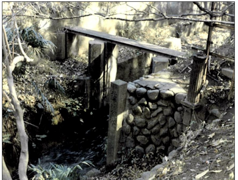
写真 II-3-13-7 玉石貼り囲まれた分水口の護岸 形状がわかる。
