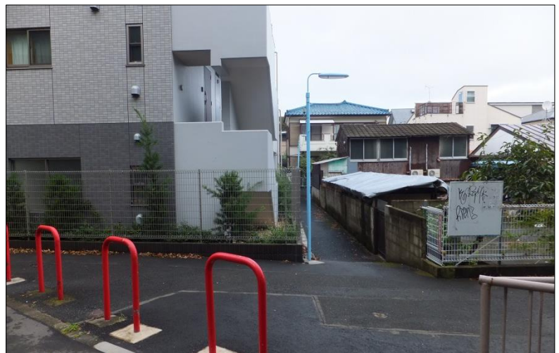
写真Ⅱ-3-14-3 高井戸分水路の跡と推定される街路を見たところ
