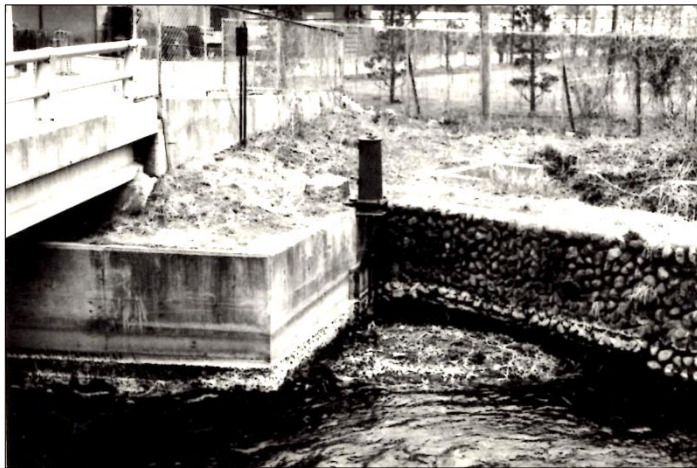
写真 II-3-6-2 松中橋のたもとの砂川分水口
