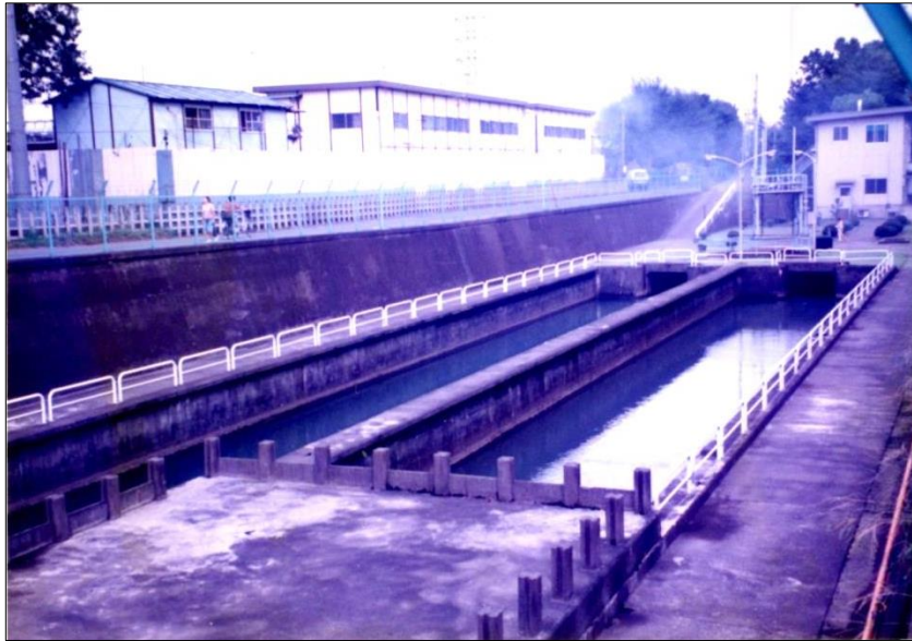
写真II-3-8-2 小平水衛所 (沈砂池)全景(1976年ごろ)
