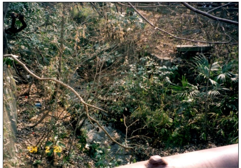
写真II-3-12-4 岩崎橋から玉川上水路右岸に残る鳥山分水口の石柱
