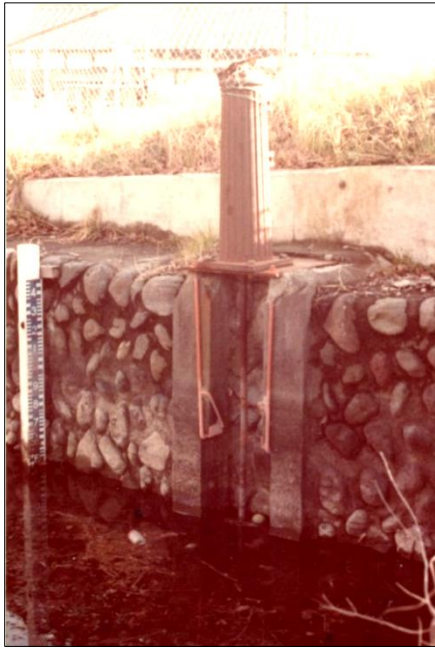
写真Ⅱ-3-3-1 差蓋のまわりを石積コンクリートで支えている。
