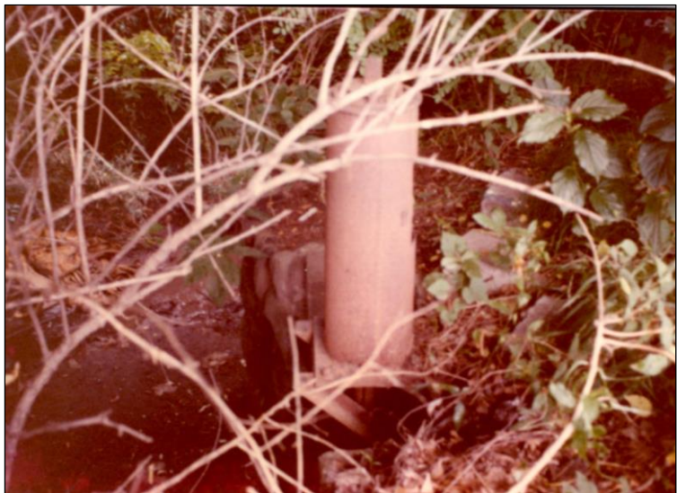
写真Ⅱ-3-10-4 中央部に差蓋を上下させるシャフ トをカバーする装置がみられる。
