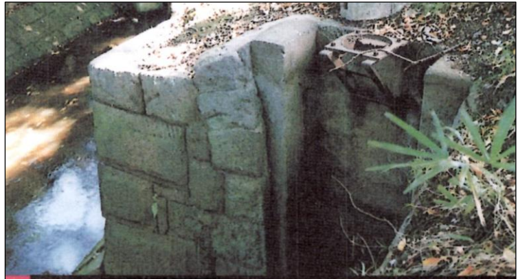
写真Ⅱ-3-10-3 分水口の「差蓋」とそれを支える支柱 (コンクリート)部分が鉄製ゲートにな っている部分の1部がみられる。
