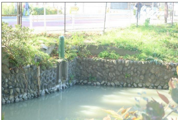
写真Ⅱ-3-3-3 中央に分水口の装置が取り付けられている。左手に水位測定版がみられる。(2019年)
