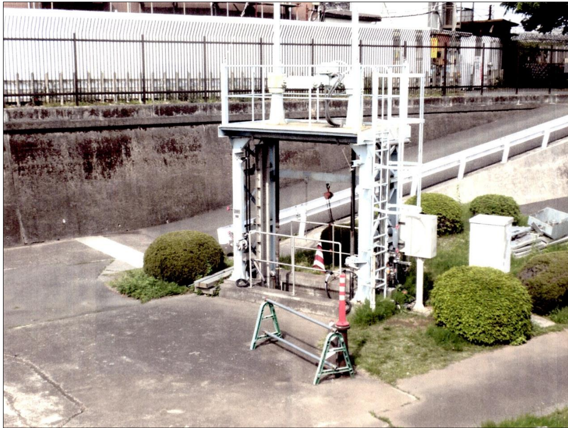
写真Ⅱ-3-8-3 野火止分水、新堀用水の分水口
