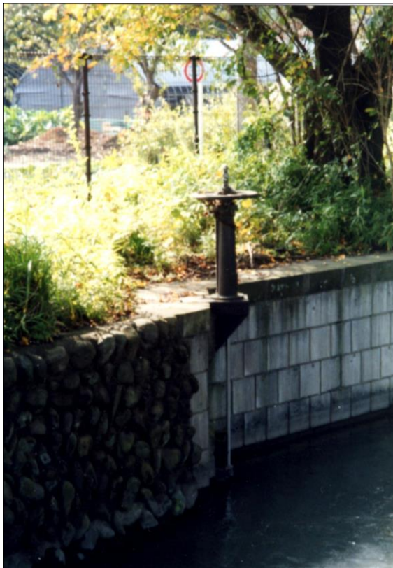
写真 II-3-7-2 源五右衛門分水口、シャフト上部にハンドルがついている。
