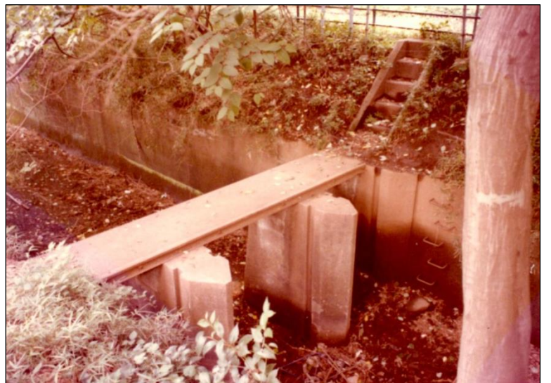
写真Ⅱ-3-11-3 牟礼分水口の下流(約10m)にある小堰 写真左が玉川上水路の下流
