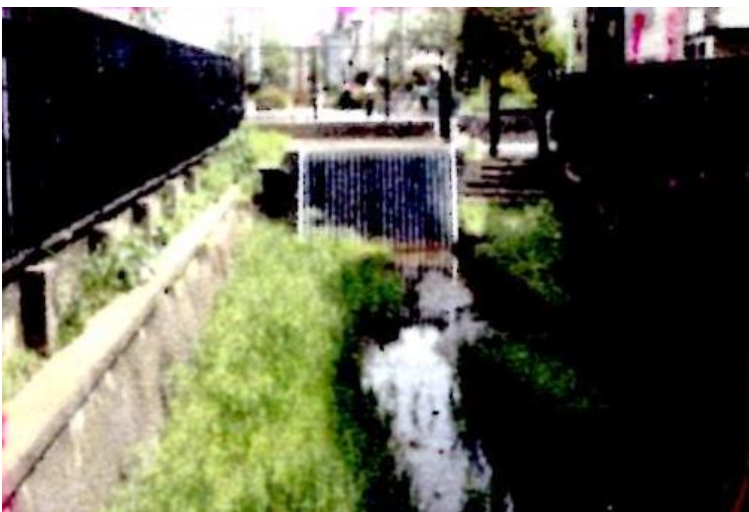
写真 II-3-16-4 三田分水口の上流部から撮影 分水口等の装置は見あたらない。
