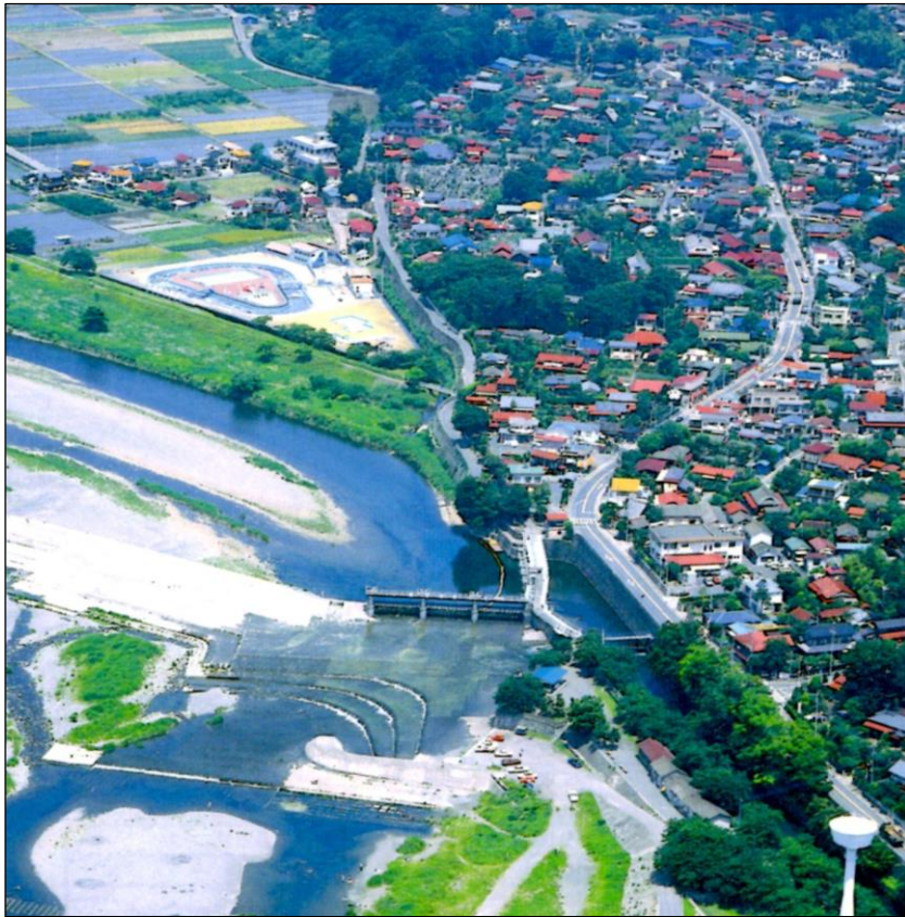
写真Ⅱ-3-A-1 玉川上水取水口周辺部のようす 「見学のしおり」より
