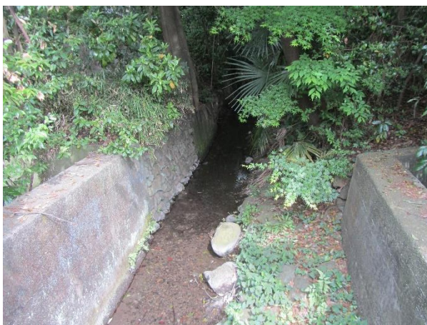
砂川用水の土管埋設場所
