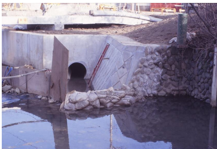
砂川用水口の工事(昭和 58 年 2 月)
