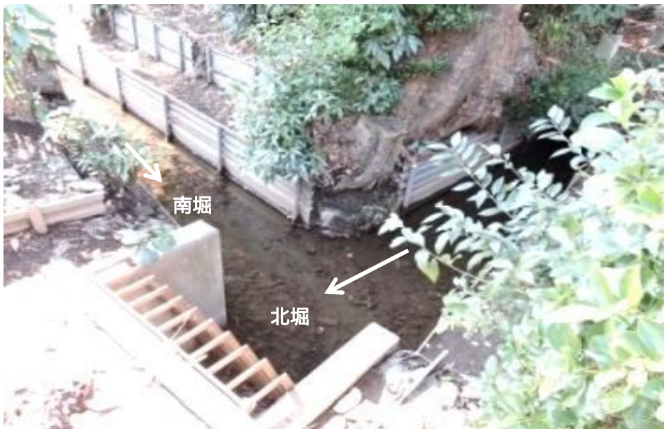
小川分水の南堀と北堀の流れが合流する地点(矢印は流水の方向)
