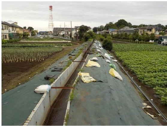
天井川の壁面状況
