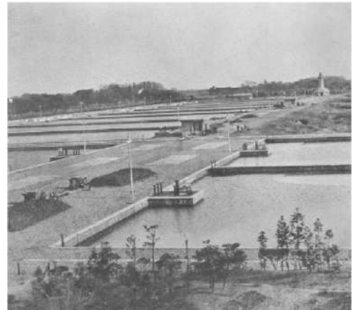
⑮境浄水場
