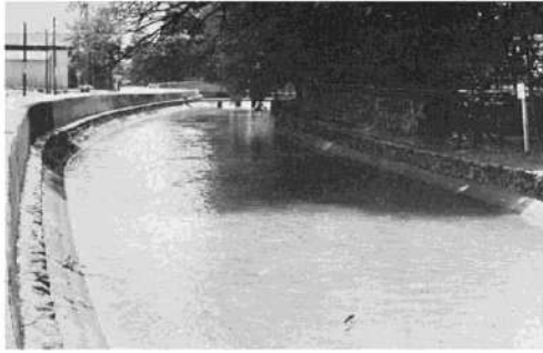
①取水所下流の玉川上水路
