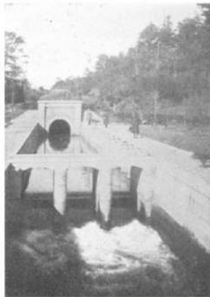
⑭境浄水場水路
