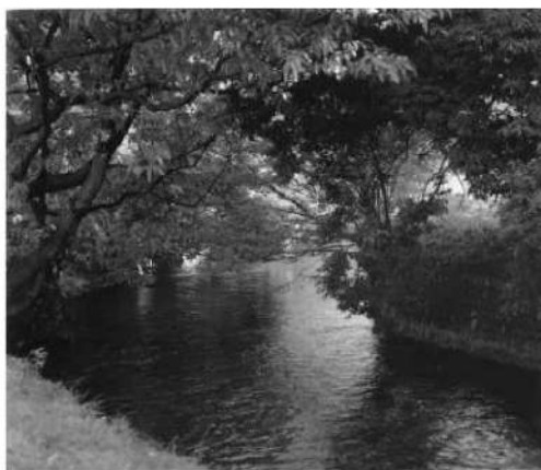
⑰玉川上水 見影橋(巴河岸跡)
