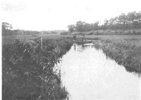
③堰入口下流
