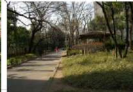
浅原橋下流の暗渠区間：水路の暗渠化により上流は公園・道筋等の利用が進む。
