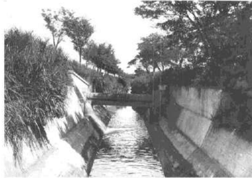
②玉川上水(境浄水場付近)
