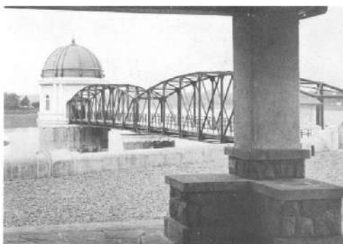
⑭村山貯水池取水塔
