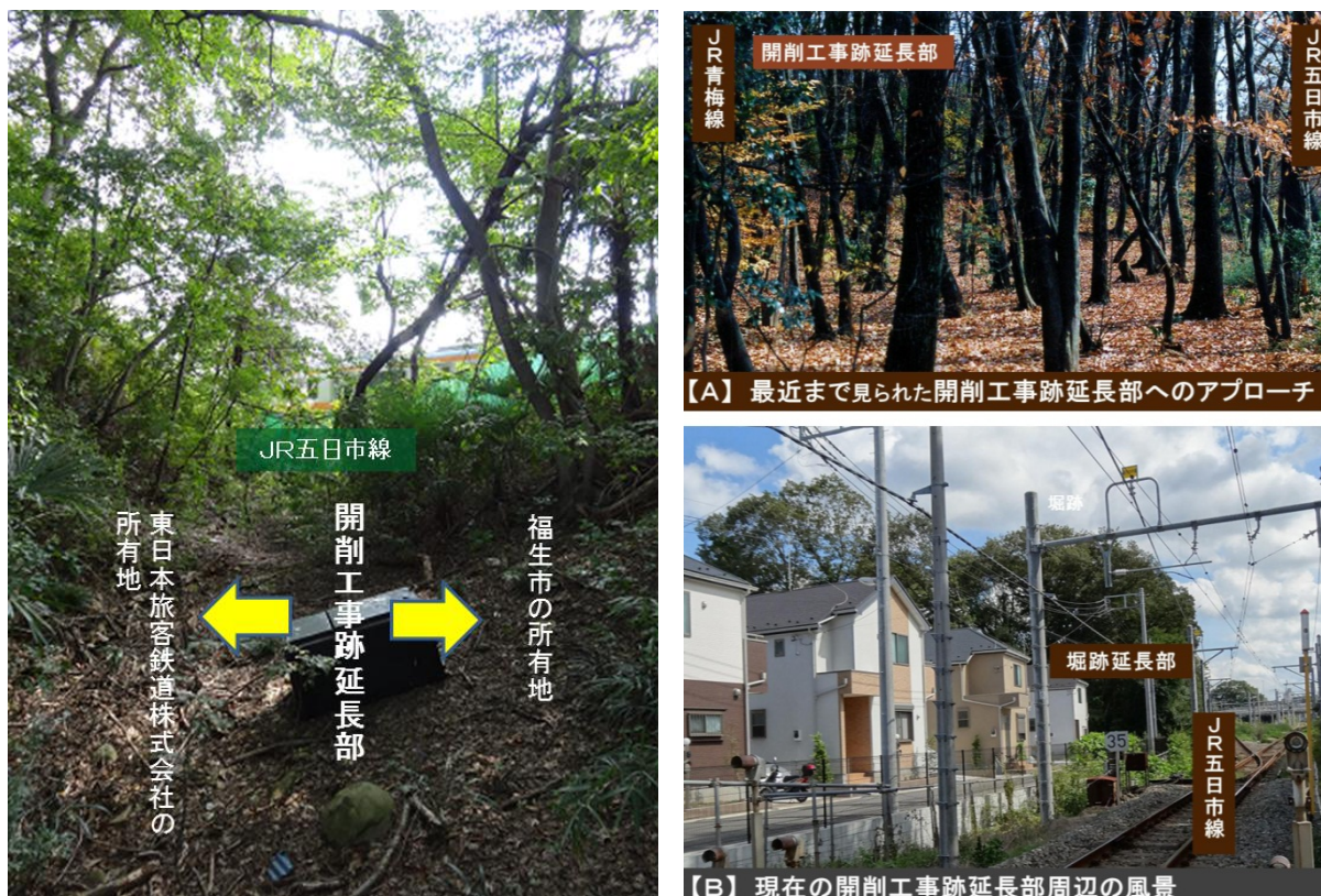
写真-26 開削工事跡延長部
