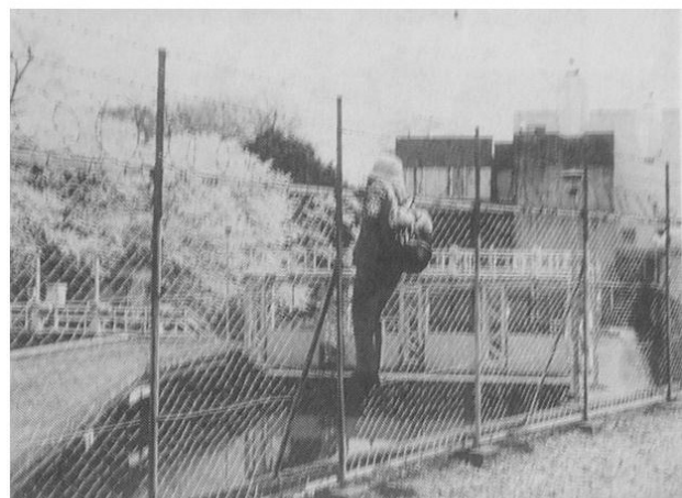
写真-5 親水性を遮るフェンス（昭和 58 年撮影）
