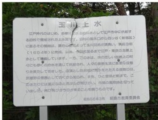
写真-11 落書きや一部破損した説明
