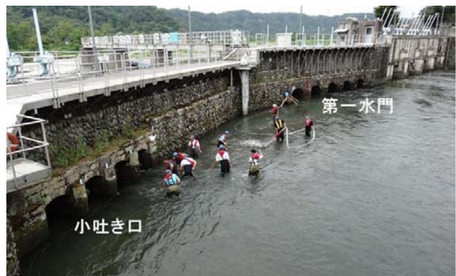
写真-4 堆積した土砂の除去作業の様子
