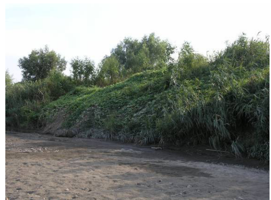
低水敷・高水敷境界の様子
