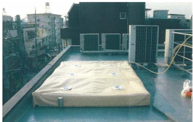
写真 ムサコ通り沿いに設置された雨水貯留緑化施設
