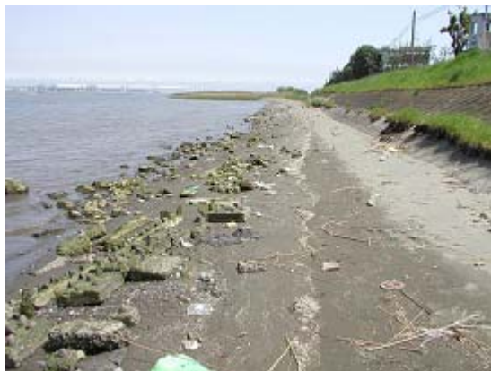
下流へ向かうと整流工（？）の一部があり、材料ブロックの散乱が見られる。いつ頃造られたのか？
