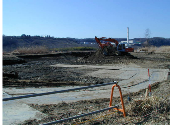
2月16日 表土の掘削
