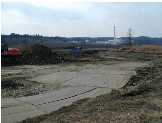
2月23日 中間の深さくらいまで掘削
