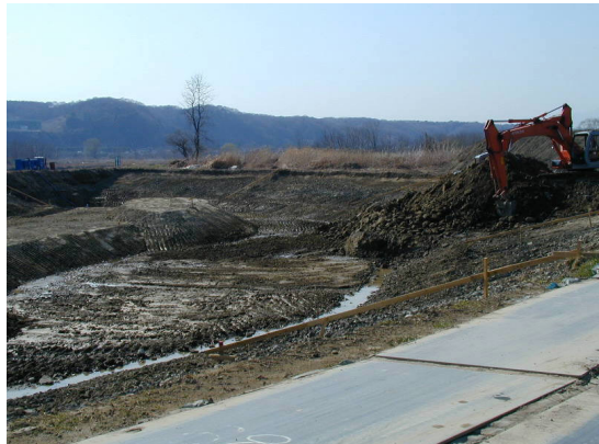
3月9日 掘削ほぼ完了
