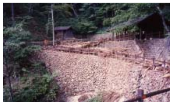
写真6 土石流によって破壊された登山道
