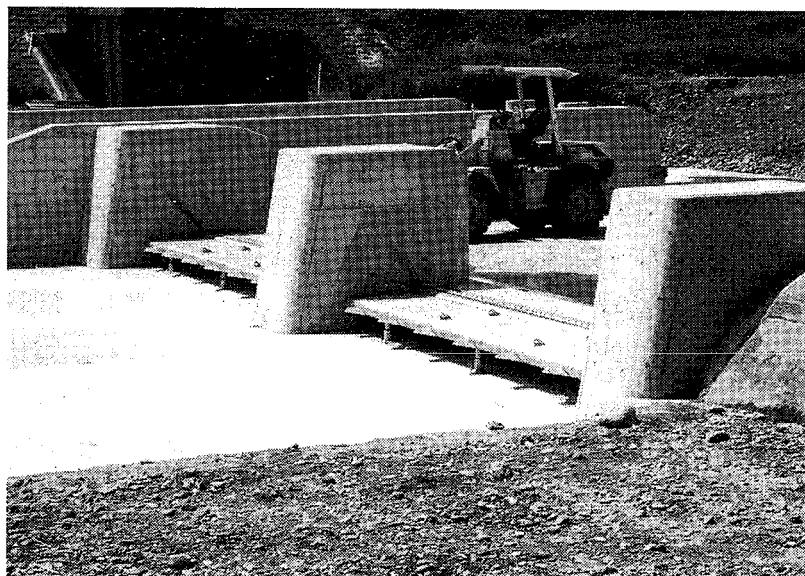
転倒堰（ゲートが倒れている状態）
