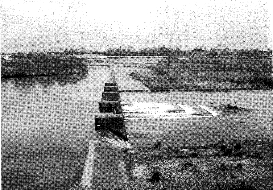
改修前の日野用水堰
