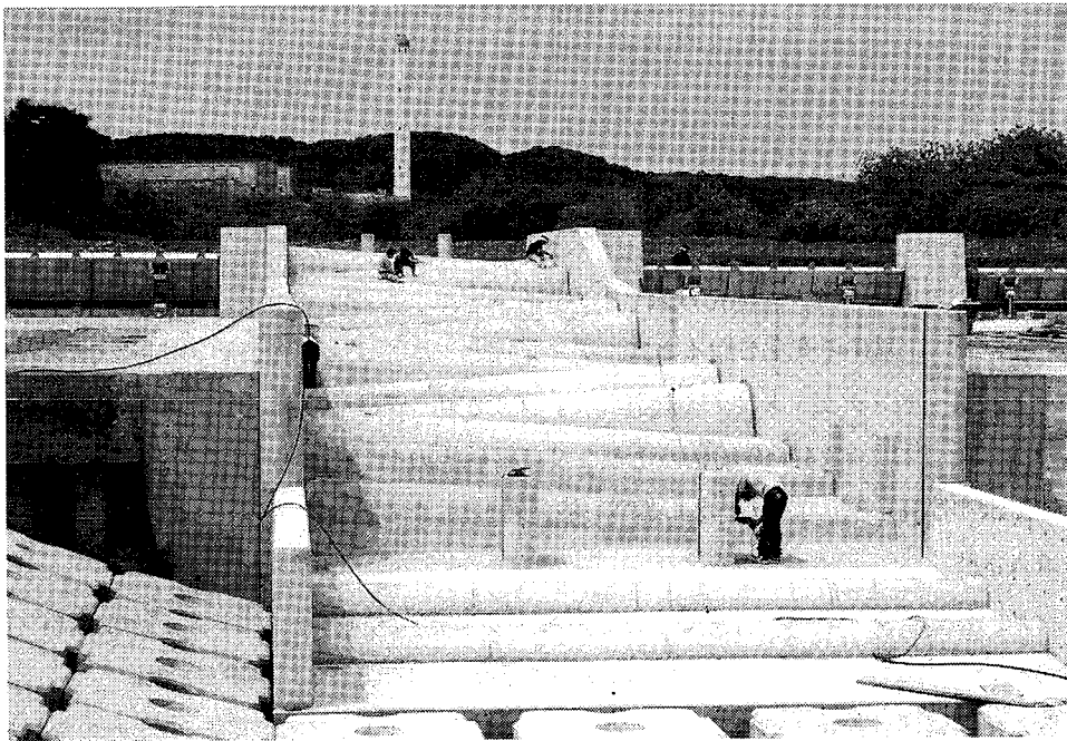
改修工事中の日野用水堰
