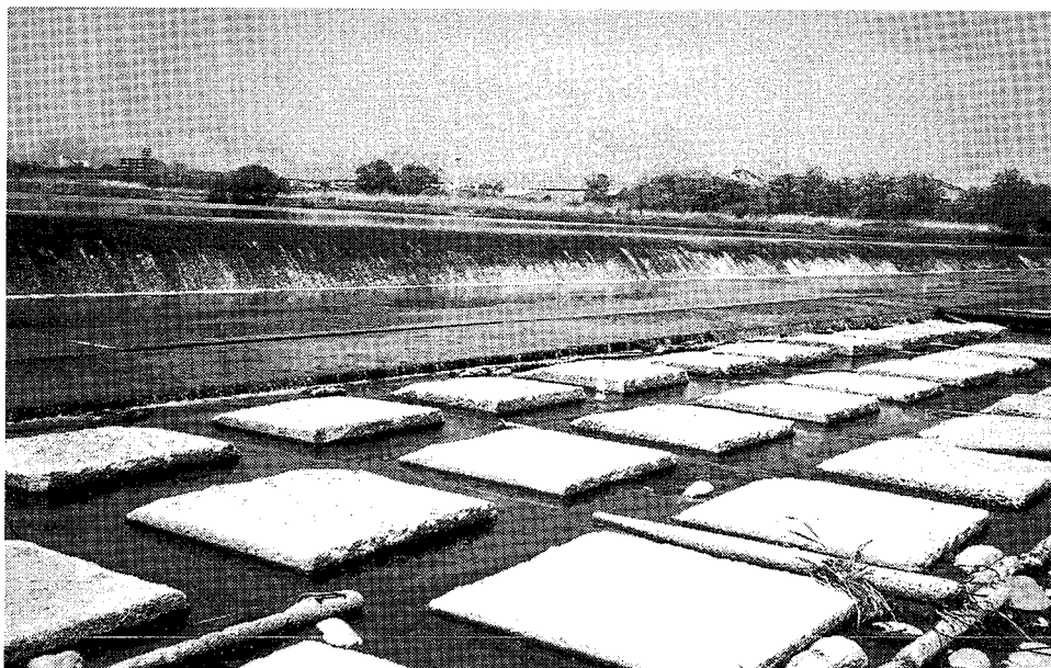
コンクリート沈床（日野用水堰）
