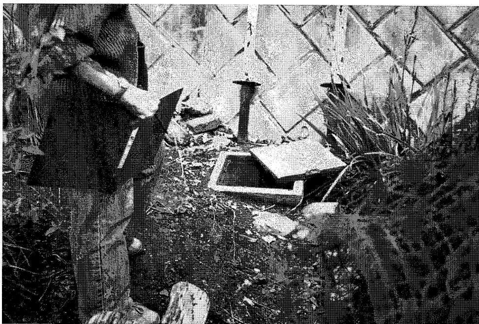
17. 受水を貯めるコンクリート製受水槽（横井戸）
