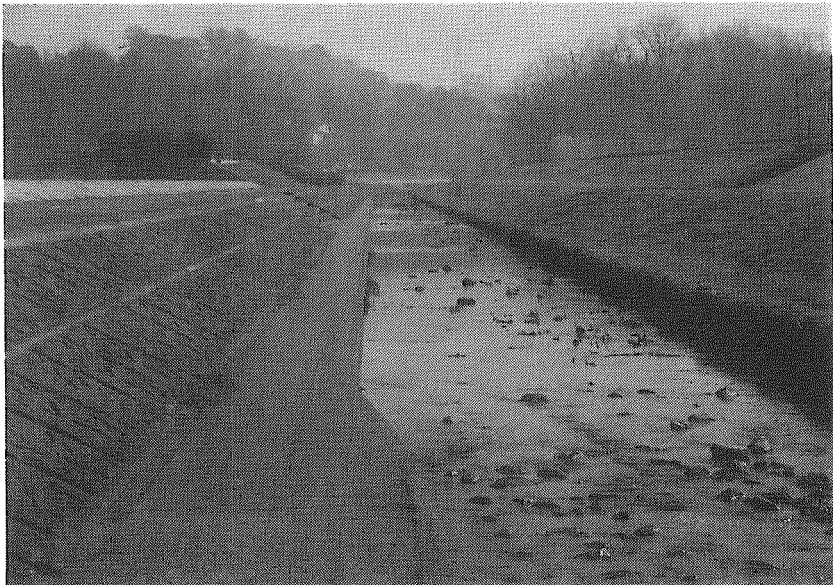
調節池上流より野川公園方向を見る
