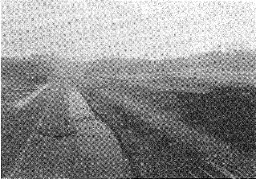
調節池上流の橋から野川公園方向を見る
