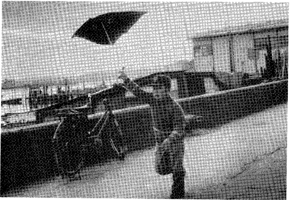
写Ⅱ-1 羽田の赤レンガの堤防（昭和57年1月・石原裕之撮影）
