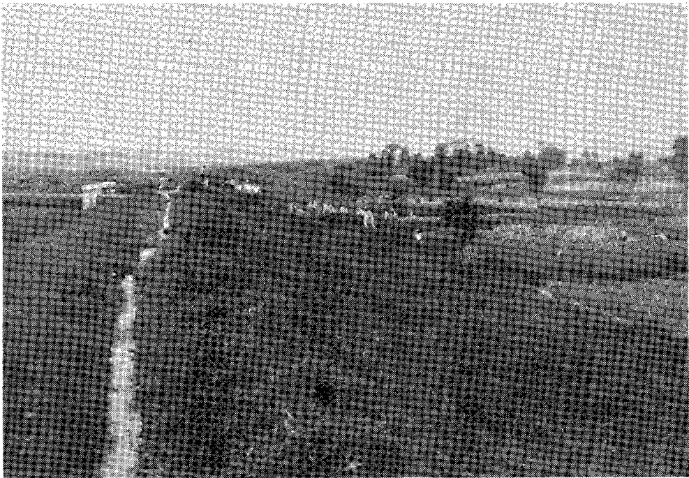
写II-19 昭和4年ガス橋人道橋付設後のガス橋通り建設工事 (当時の堤防と堤内地の状況がよくわかる)
