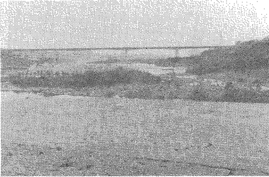
堰から、多摩川の下流側をながめる。水量が極めて少ない。
