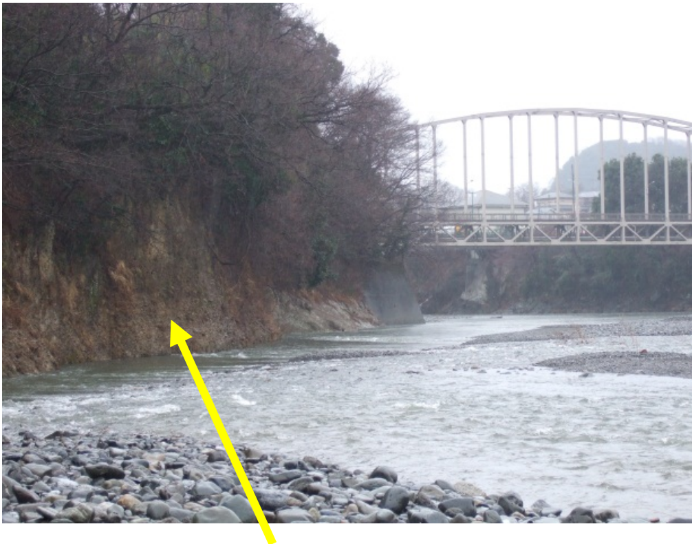
図6 増水などで河岸の泥が削られる
