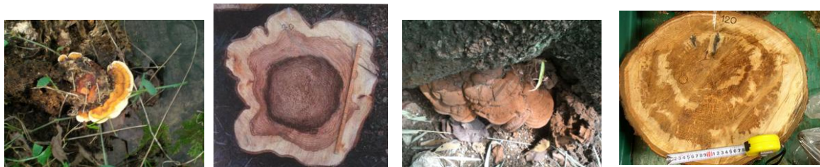
図-3. 腐朽菌の子実体と樹木内部の腐朽
