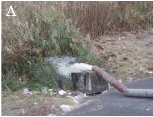
図 7-2 土管からの排水の様子(A)とその管轄に関する掲示(B) 調査目標としている干潟のやや下流に土管が配置されており、非恒常的に(日に数回程度)干潟に地下水が排水される。地下水が排水される付近のヨシは他の地点と比べて大きく育っており、地下水からの栄養塩の供給が予想されたが、本研究によって、供給される地下水は真水で、栄養塩として主に硝酸性窒素が含まれ、その濃度や窒素・酸素の安定同位体比は季節により増減することが明らかにされた。地下水の排水設備は東日本旅客鉄道株式会社が設置管理を行っているようだが、地下水の起源や流量に関しては依然不明である。
