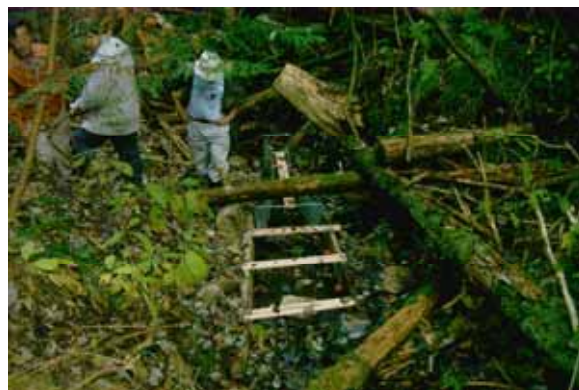
写真 16-4 倒木だらけの新設時の上流堰
