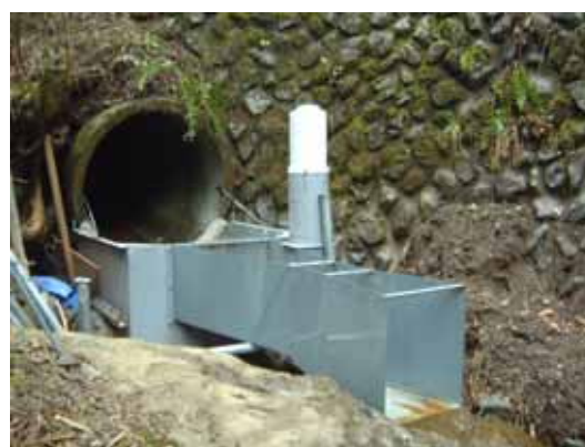
写真 9.2 同左大型の堰に交換
