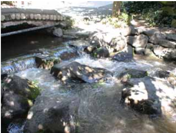
写真 17-3 井の頭池出口
