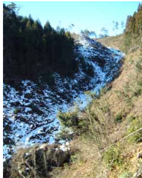
写真 15.2 樽沢下流部の V 字
