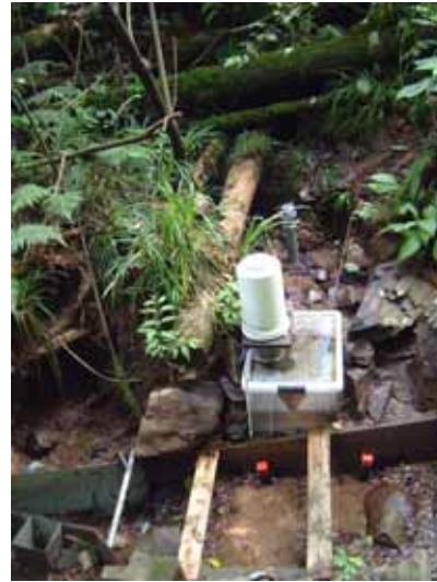
写真 9.7 上 2 堰 本流に合流する支流出口に設置
