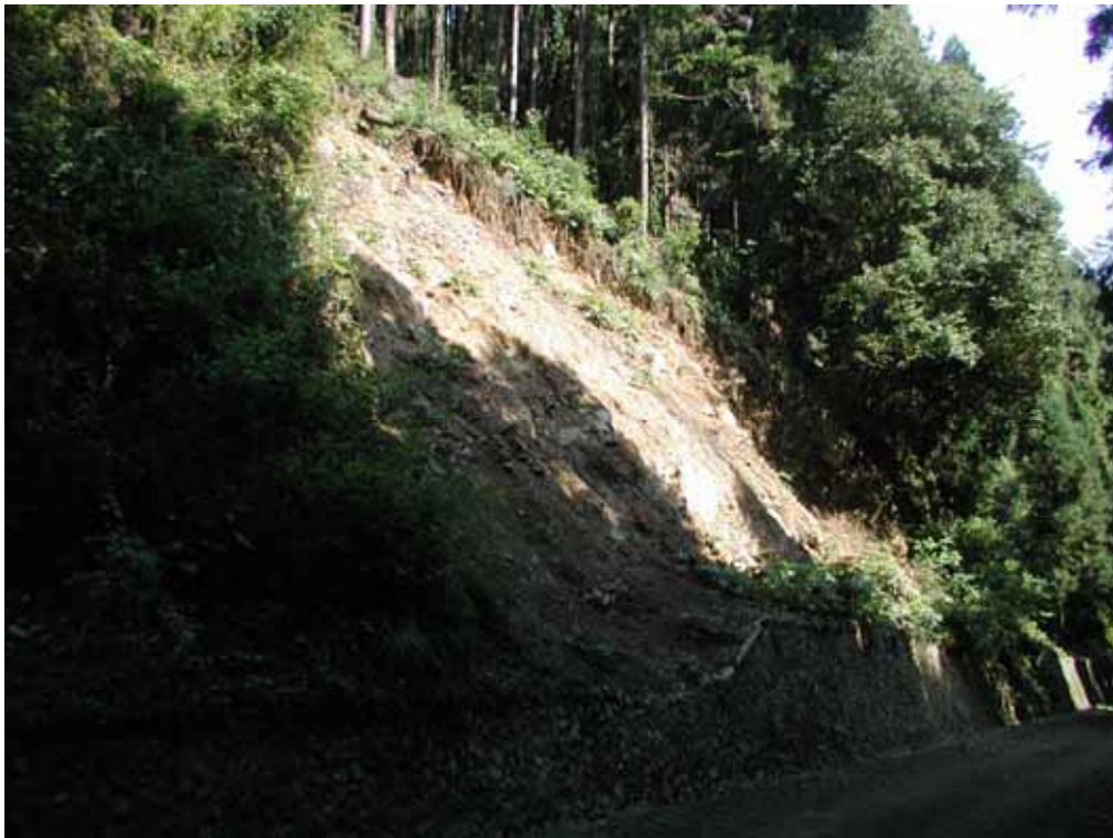
写真3 台風によるのり面の崩落
