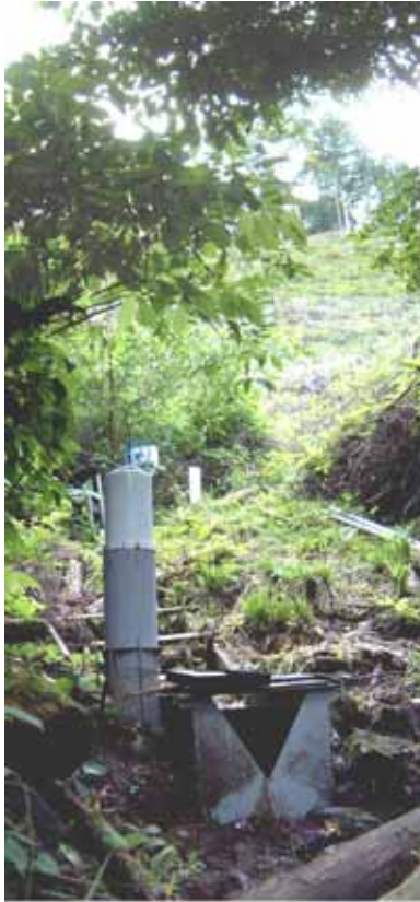
写真 9.6 上流堰 樽沢源頭部に位置する
