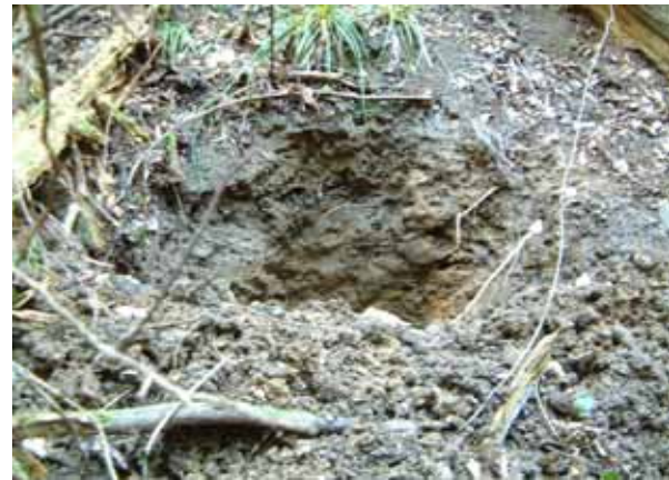
写真 15.4 斜面末端部のグライ化した崩積
