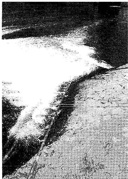
写真 2(b) 簡易魚道設置後の流況
