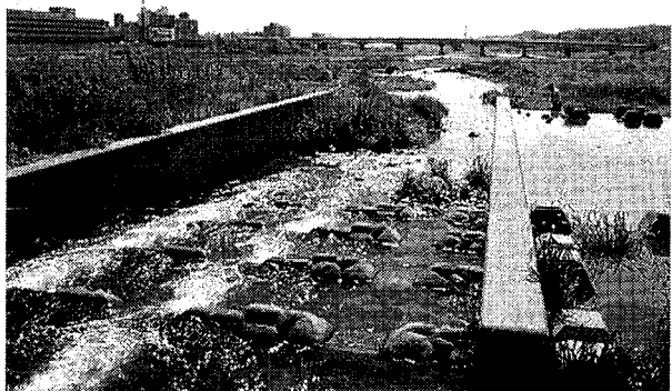
写真 18-3 下流に向かって魚道の流れを見る
