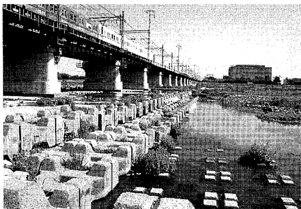
写真 18-1 護床ブロックを越える流れ
