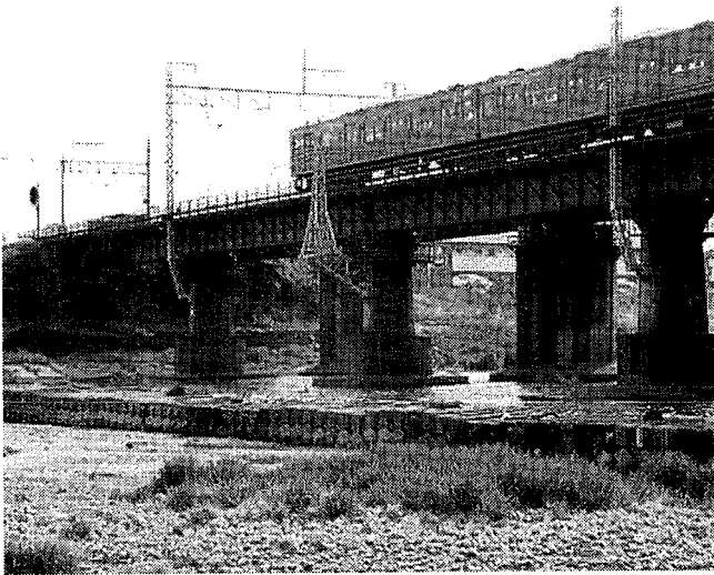
写真 15-2 JR 中央線鉄橋下床固め工
