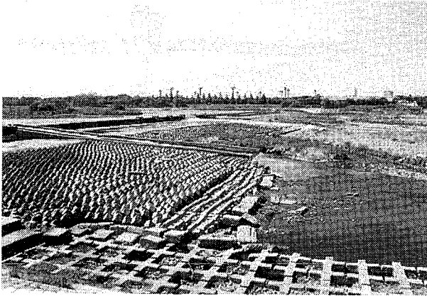
写真 19-1 大丸用水堰(魚道の両側に護床 ブロックが設置されている)
