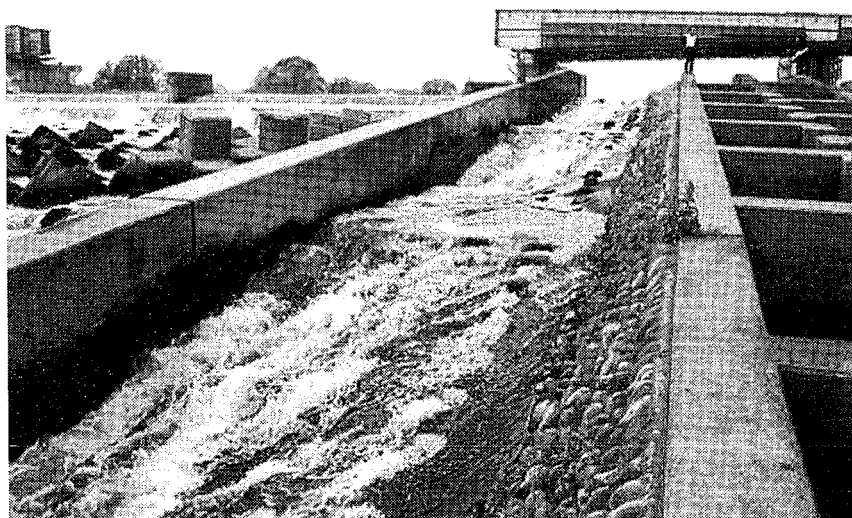
写真 16-2 四谷本宿用水堰(粗石を張った斜路(魚道)を流れる状況)
