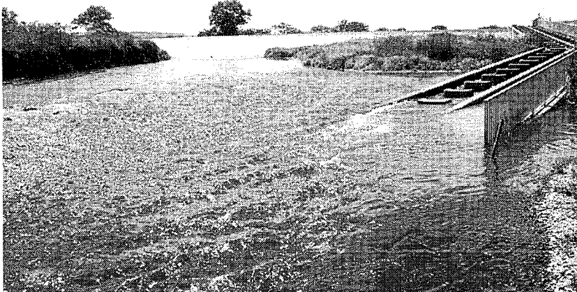
写真 22-2 二ヶ領上河原用水堰左岸側(魚道入口近くの流れの状況)
