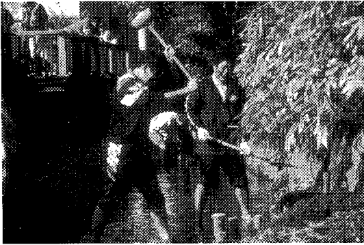
写真6-14 杭の正しい打ち方
