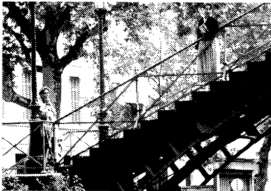
写真5-10 サン・マルタン運河のアーチ橋
