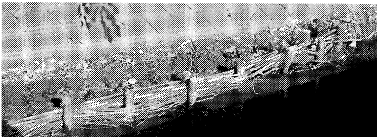
写真6-11 丸子川での竹編柵工
