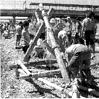
写真6-24 蛇籠の枠を取り付け
