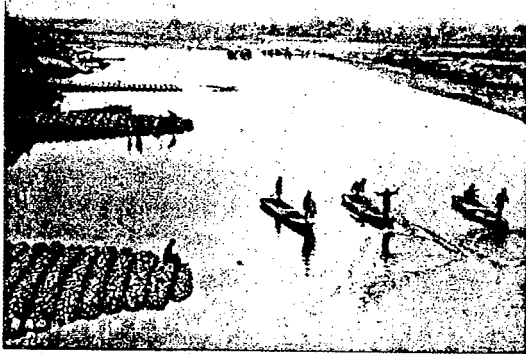
写真1-15 投網漁と蛇かごの水制
