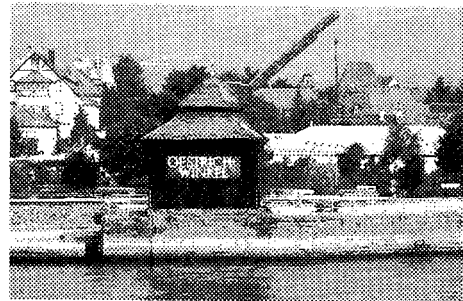
写真3-11 川沿いの古いクレン
