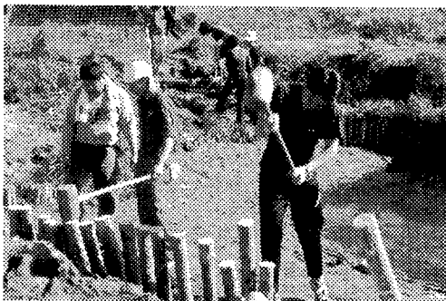
写真5-17 間伐材を利用したワンドづくり
