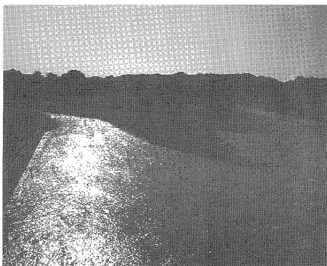
写真-3 羽用水の堤外導水路の上流端
