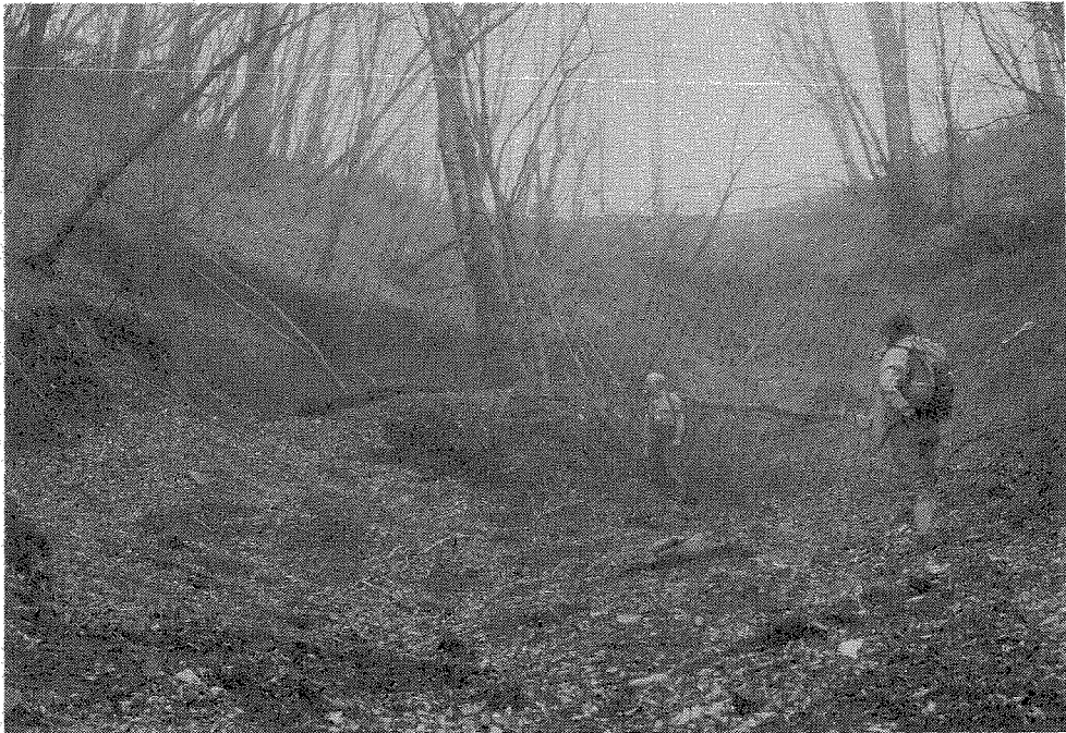
写真11 谷頭の浅い崩壊地 (A溪流)
