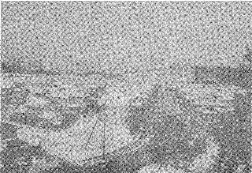
图 2.8 住宅地（南陽台団地）
