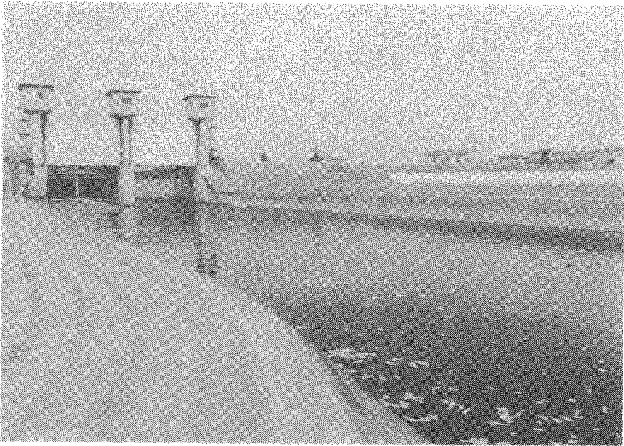
写真14 St. 11 府中污水处理排水路
