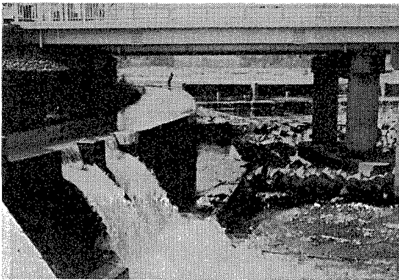
写真4-3 高月取水堰および用水路
