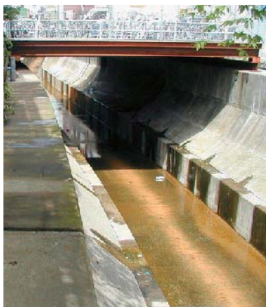
写真一 三面張りの渋谷川(渋谷駅下流)
