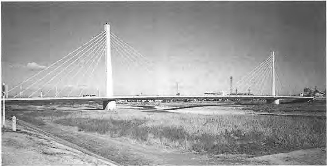
'98年12月17日完成した「府中四谷橋」
