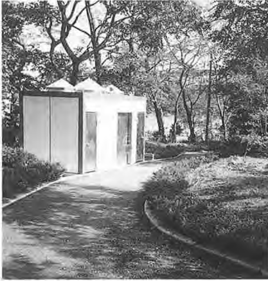
多摩川兵庫島公園内に設置されたバリアフリーのトイレ ('98年4月)
