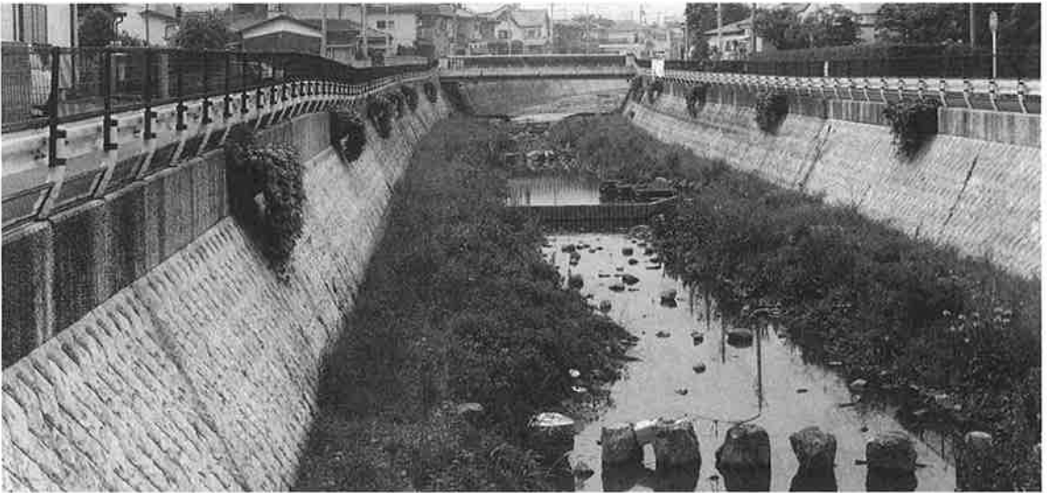
残堀川・砂前橋より上流を望む('97.5.16撮)
