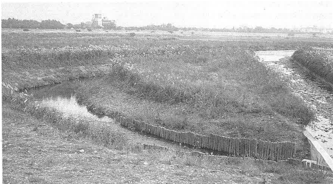
右手の程久保川から引き入れた生態水路。奥が多摩川本川 (H 5年10月撮)
