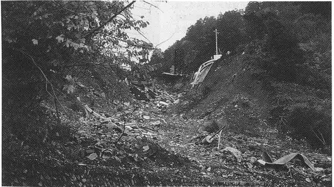
土砂崩れによる道路の崩壊地。(檜原村都民の森下 '91.11撮)
