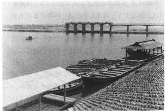
登戸地先宿河原堰堤の湛水池
