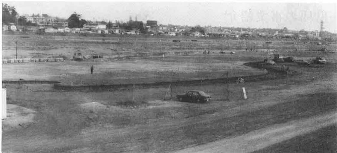
第三京下の公園工事風景
