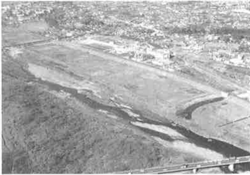
多摩川上流処理場・1989.12撮
