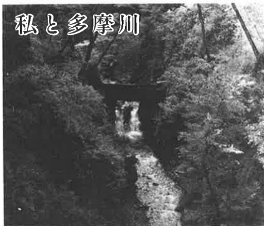
峡谷の後山川に設けられた鉄砲出の残り 昭和31.4.25(筆者撮)
