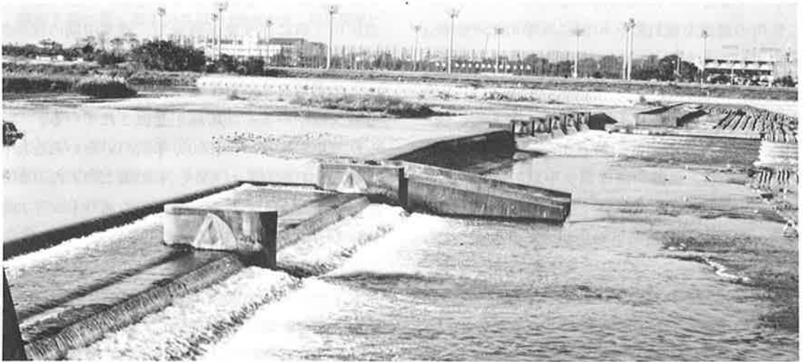
二ヶ領用水上河原堰・1611年開削された稲毛・川崎・二ヶ領用水の取水口として設置され現在に至る
