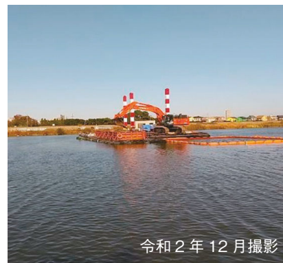
河道の土砂掘削中（水上から）
