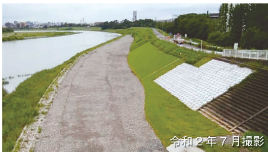
災害復旧完了（堤防復旧）
