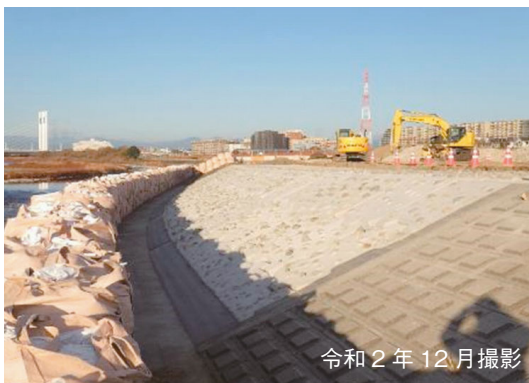
災害復旧実施中（護岸ブロック設置）
