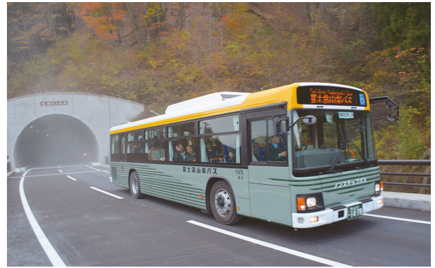
松姫トンネル開通
