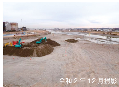
河道の土砂掘削中（陸上から）
