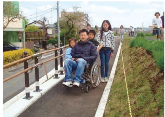
緩やかな土手スロープが完成
