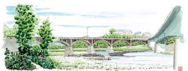
10 東秋留橋 左側のコンクリートアーチ橋は「近代土木遺産」に登録されている名橋。それに代わる新橋が右の鉄骨ボックス梁
