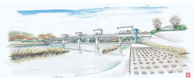
小作堰 ここで取水される水は画面右奥にある沈砂池で浄化され埼玉県の山口貯水池へ導水される。
