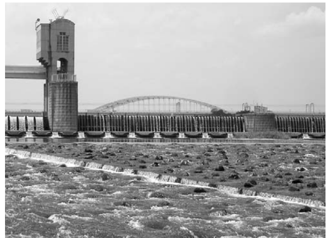
宿河原堰 川崎側から
