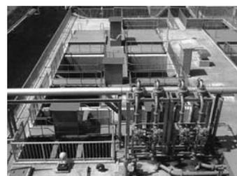
生田浄水場の超高速凝集沈でん池。フランス生まれの優れたもの〔川崎市上下水道局の資料から〕
