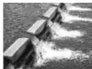
宿河原堰副ダム下流側の流況
