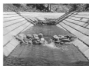
中央に切欠きを有する石積み式の台形断面魚道
