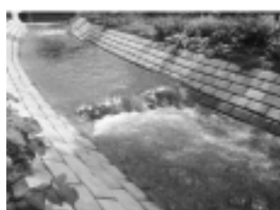
中央に切欠きを有する石積み式の台形断面魚道
