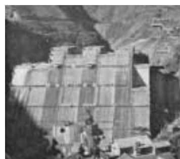
建設中（コンクリート打設約60%）
