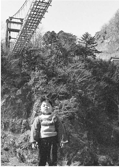
「改架中の神代橋」(昭和39年2月)
